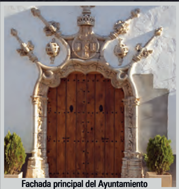
Fachada principal del Ayuntamiento
